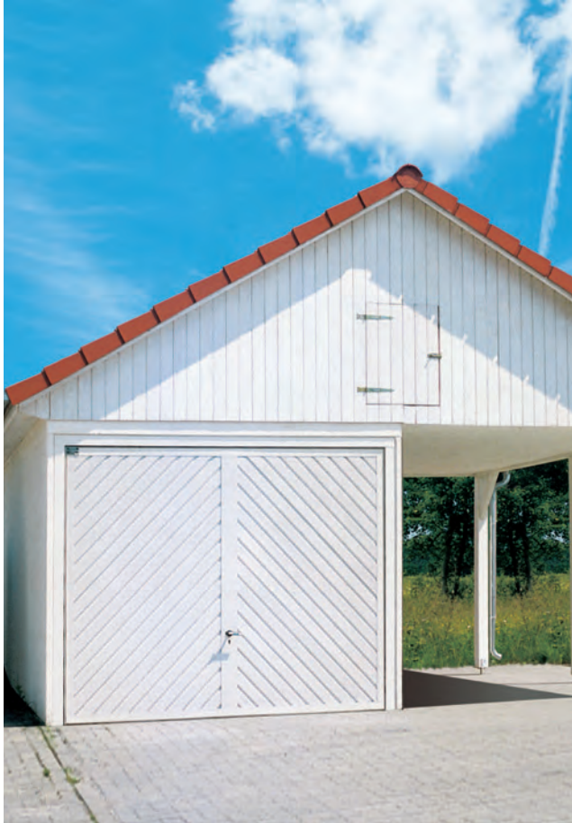
Standardgarage mit Carport unter einem Satteldach
