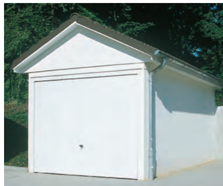
Standardgarage unter einem Satteldach
