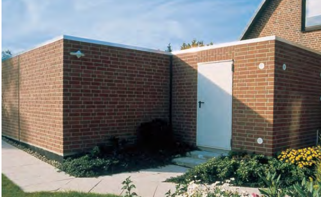
Garage mit Geräteraum, Verblendung und Stahltür
